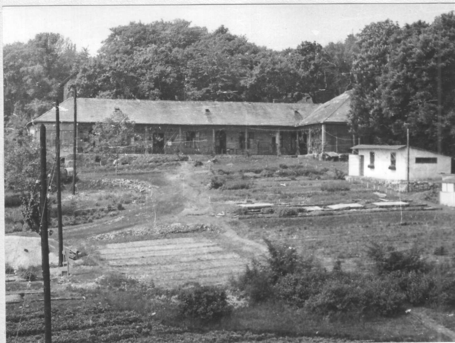
Az örökölt tornácos épület, és a zsírosládából készült fabarakk /1962/
