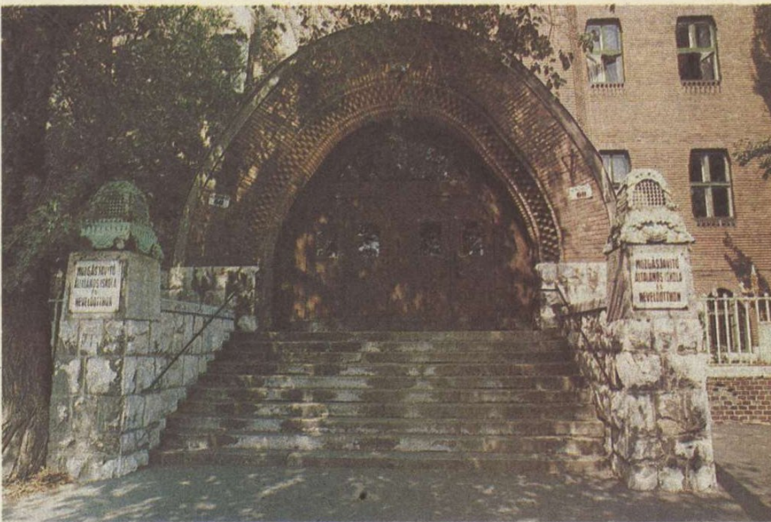
Egy a visszaigényelt épületek közül: a Mexikói Úti Mozsásjavitó Általános Iskola
