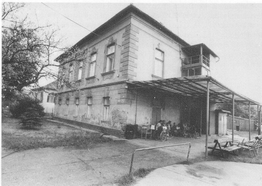
Az iskola épülete
